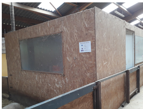
Exemple d'un local aménagé dans la bergerie.
